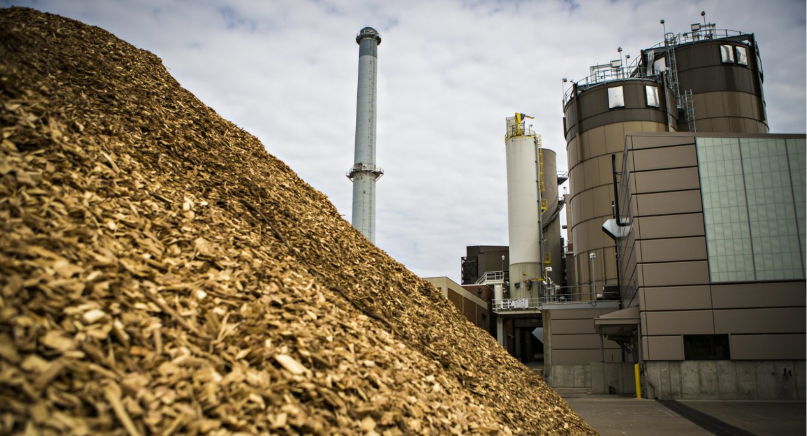
Copeaux de bois dans une centrale électrique à biomasse aux États-Unis. CANFR/Flickr
