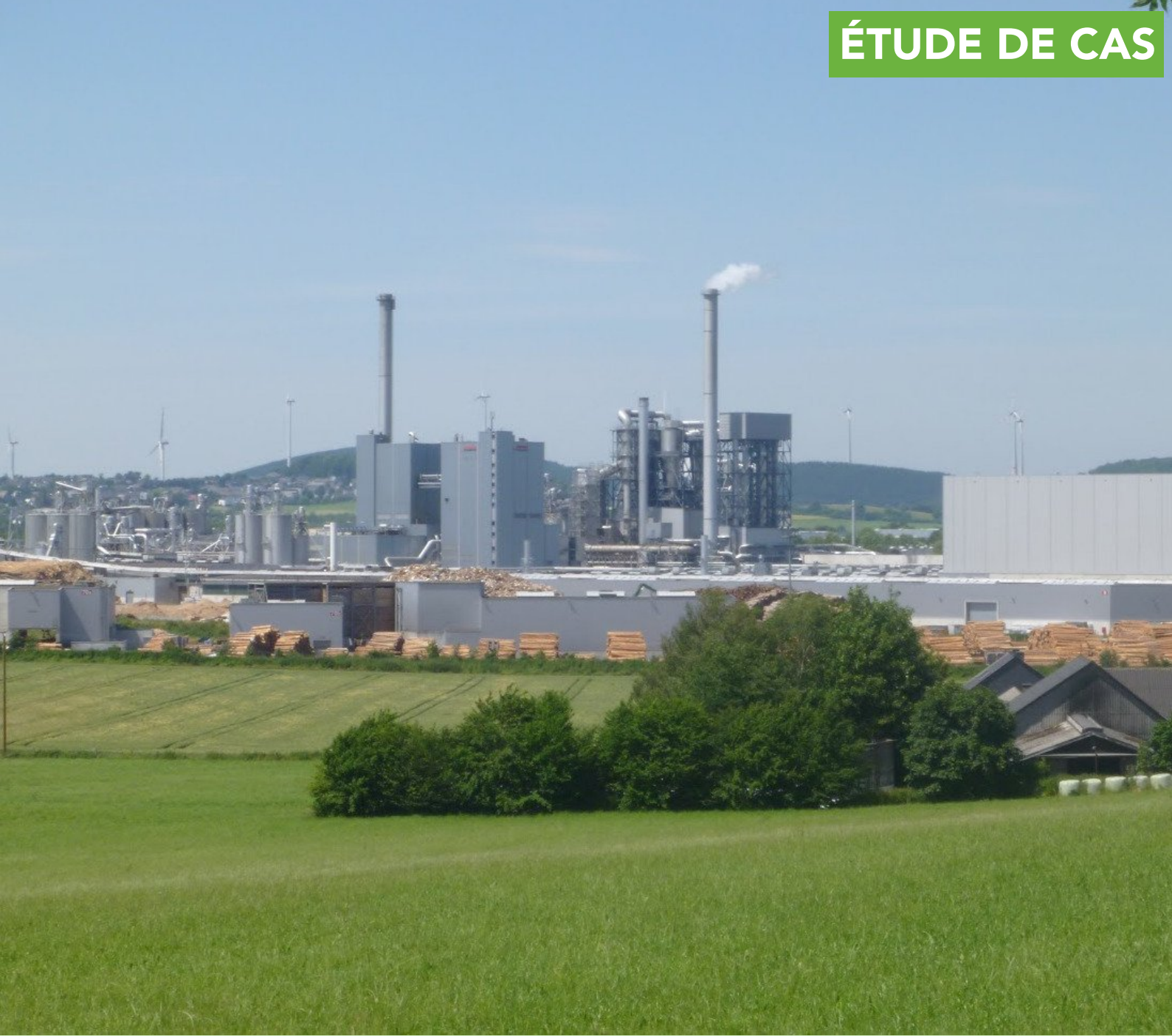
Centrale bioénergétique Egger Holzwerkstoffe Brilon GmbH & Co. en Allemagne. Bomenstichting Achterhoek
